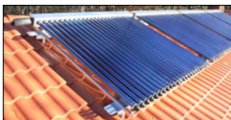
Exempel på tegeltaksinfästning
