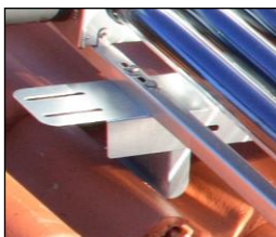
Närbild på tegeltaksinfästning
