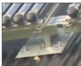
Närbild på monterad infästningsplåt
